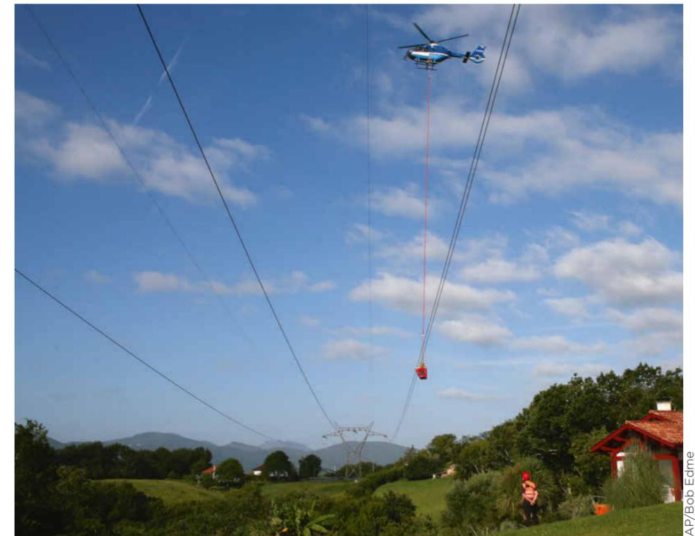
**Opération de haut voltage.** À bord d'une nacelle attachée à un hélicoptère, des techniciens de Réseau de transport d'électricité (RTE), le gestionnaire du réseau public, travaillent sur des lignes à très haute tension, près du village d'Ascain, le 10 août. Ces installations relient les réseaux français et espagnol.
